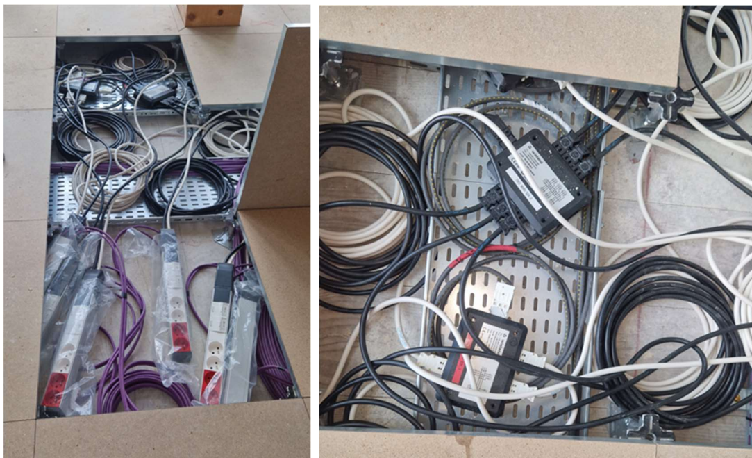
Photos des distributeurs et nourrices en attentes sous faux-plancher
